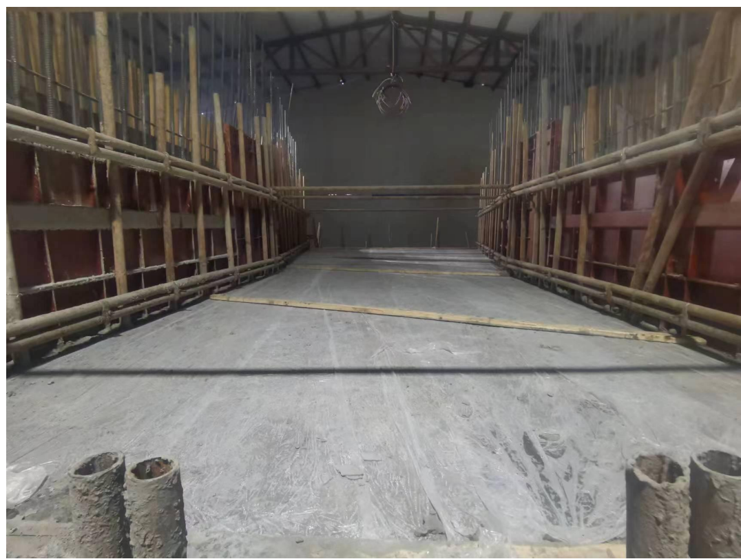
图片 5：围堰建设（1）
