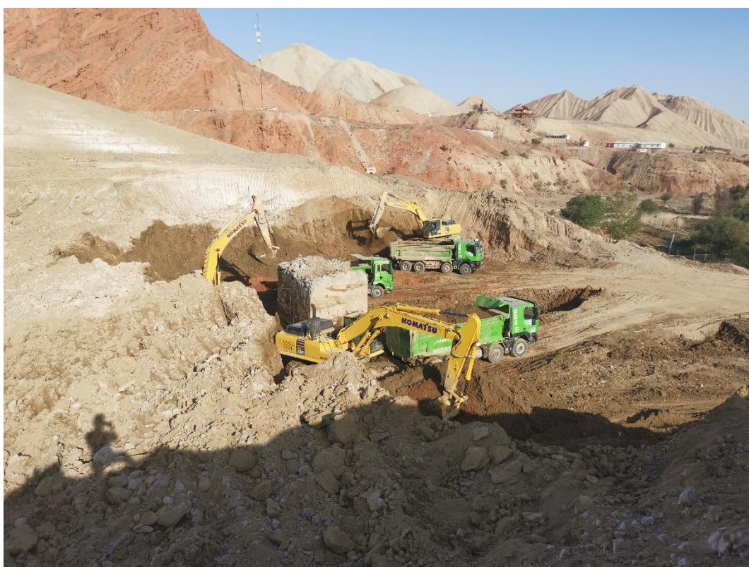
图片 4：坝体开挖（2）
