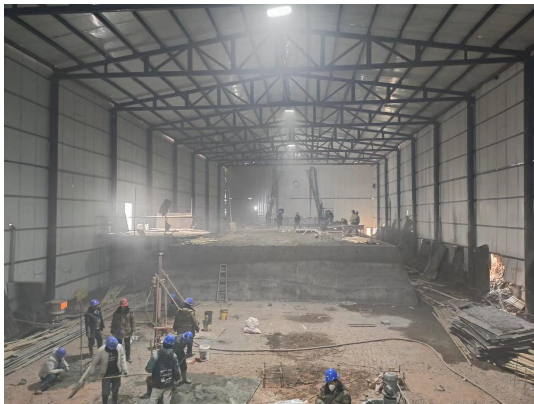
图片 6：围堰建设（2）
