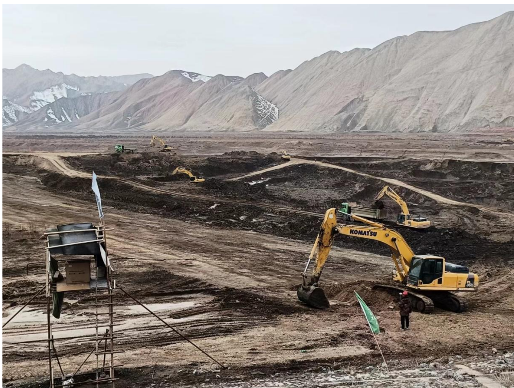
图片 3：坝体开挖（1）
