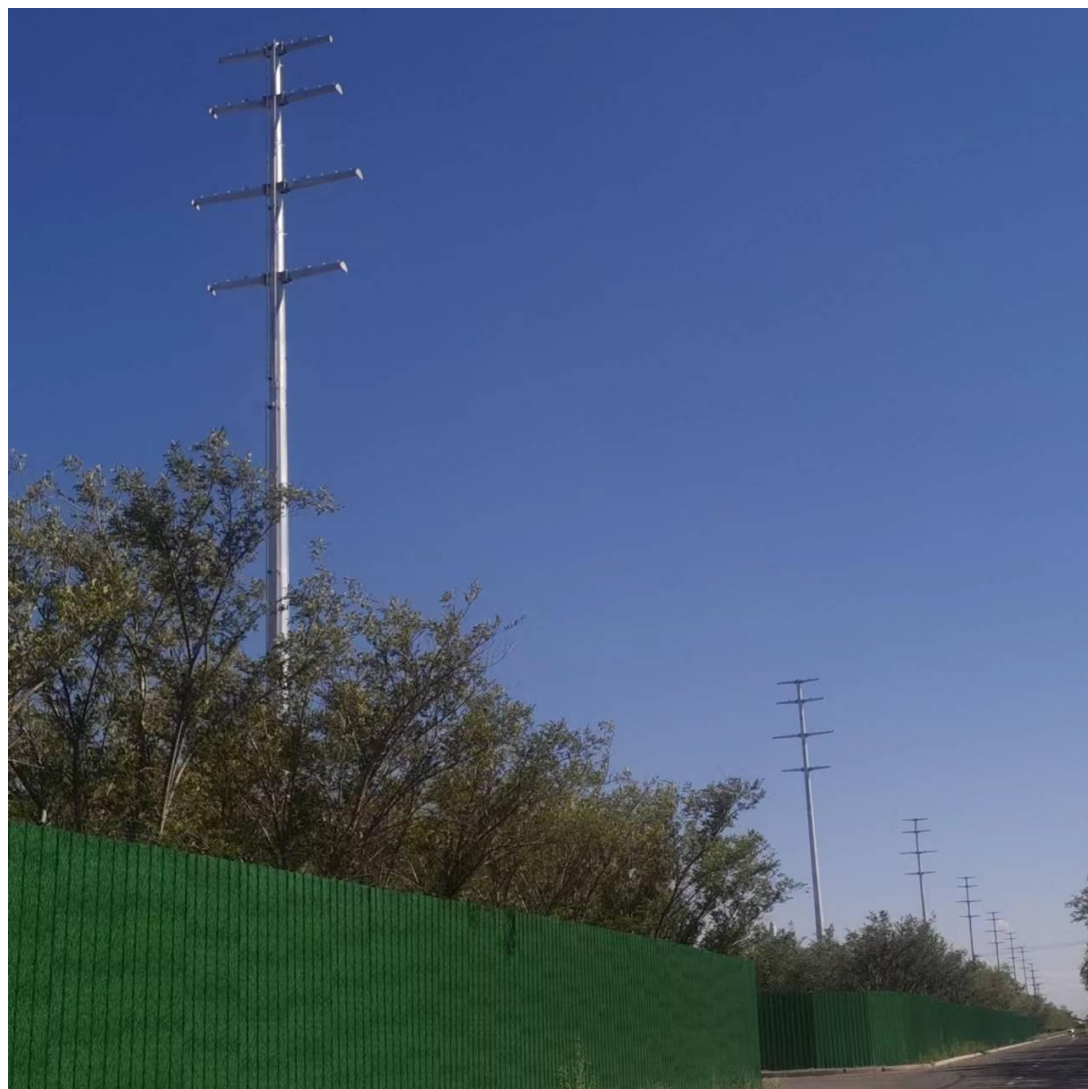
图片 1：现场勘查照片（1）
