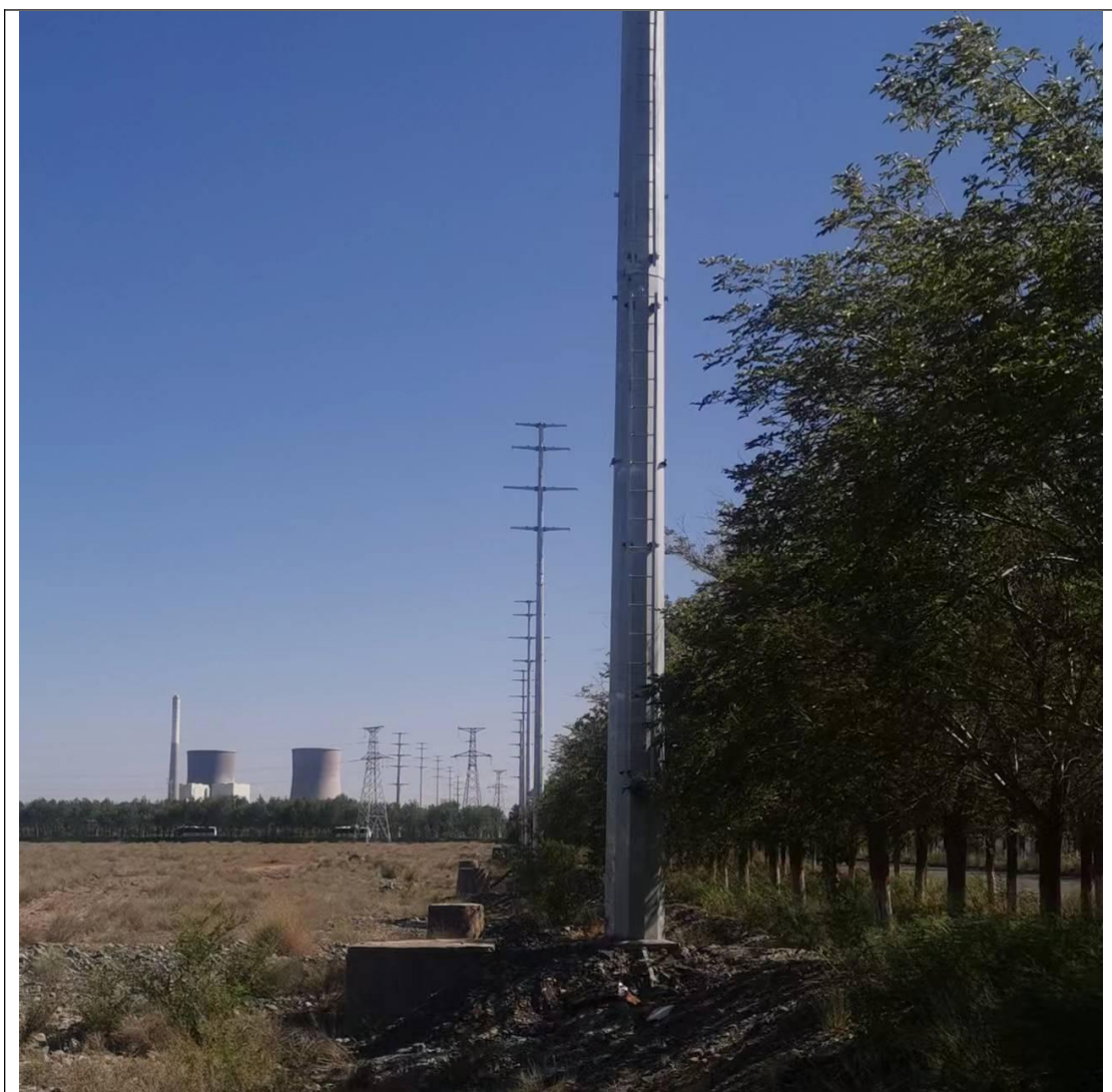
图片 2：现场勘查照片（2）
