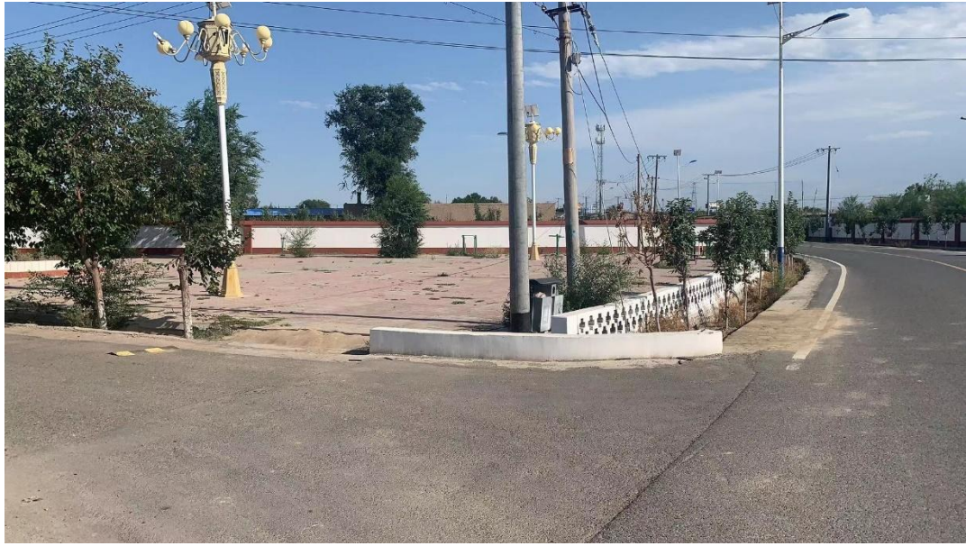
图片 3：现场勘查照片（3）
