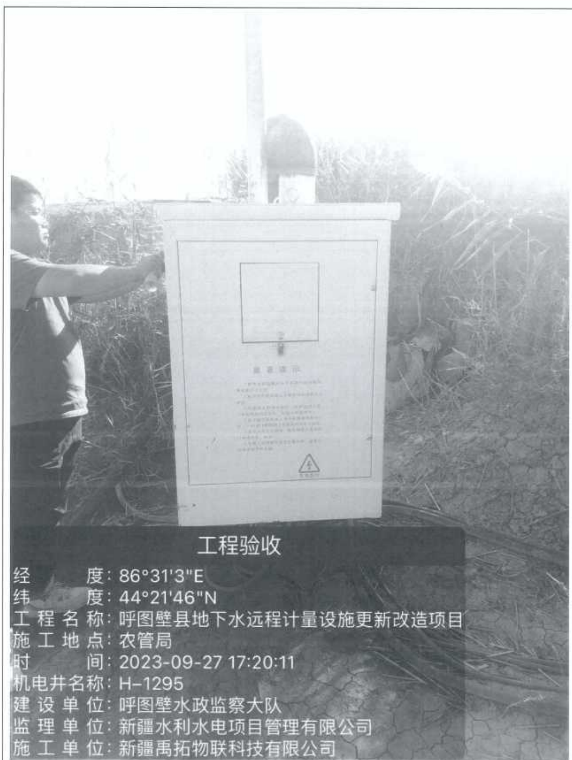
图片 3: 现场勘查照片 (3)
