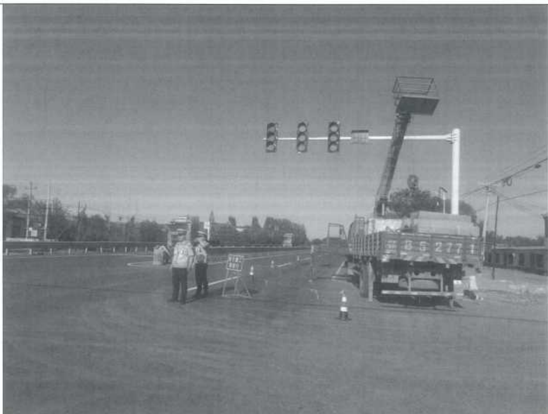
图片 1：现场勘查照片（1）
